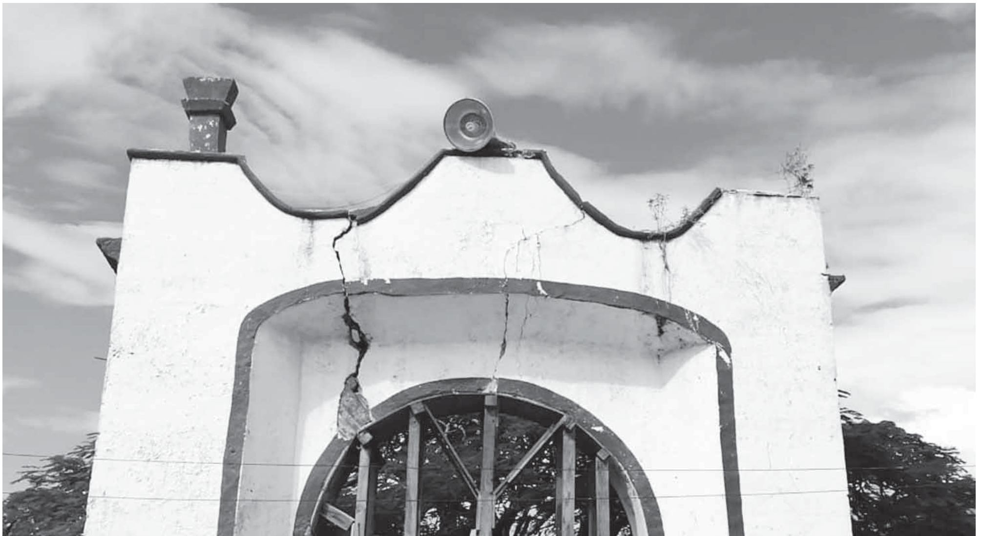
► Edificios públicos presentaron daños visibles.
