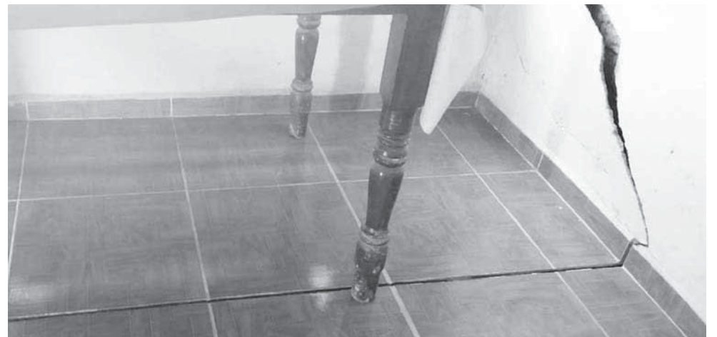
► Algunas viviendas presentaron cuarteaduras.
