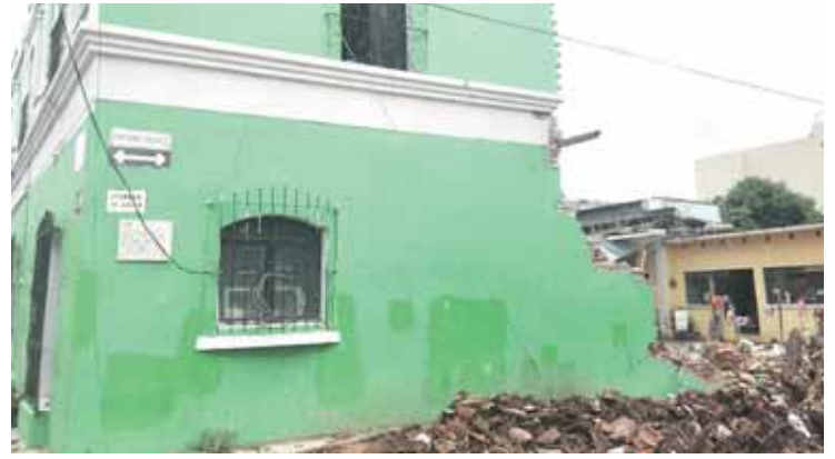
► Luego de dos años, el INAH realiza los primeros estudios para conocer el daño estructural.
