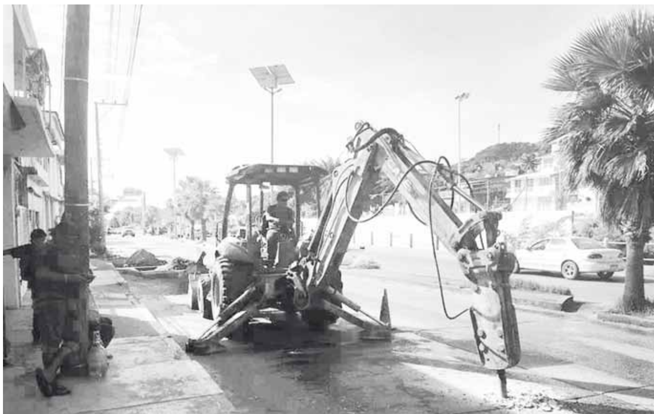
► Una maquinaria pesada demolió el pavimento para realizar los trabajos de reparación.
