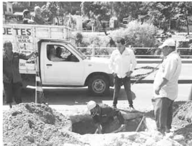
► Las tuberías tienen más de dos décadas de haberse instalado.
