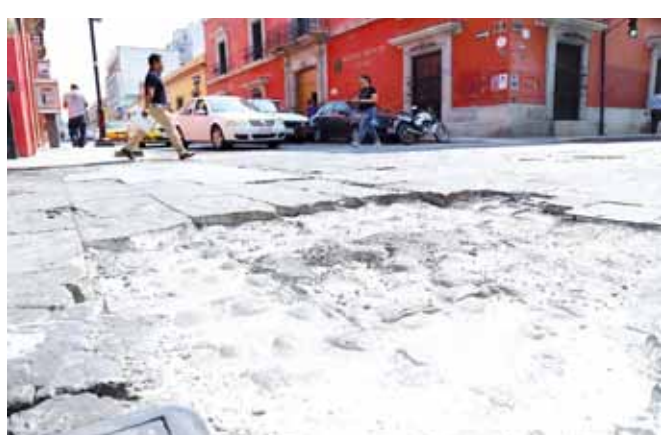
► En avenida Independencia ya se nota el deterioro de la calle.
