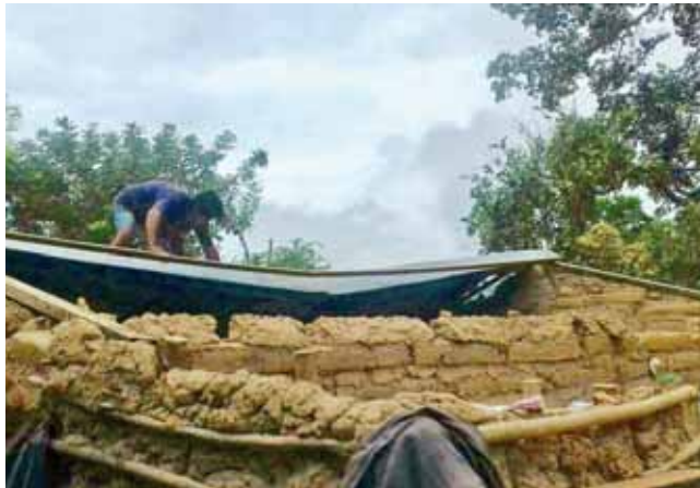
► La vivienda sufrió afectaciones.
