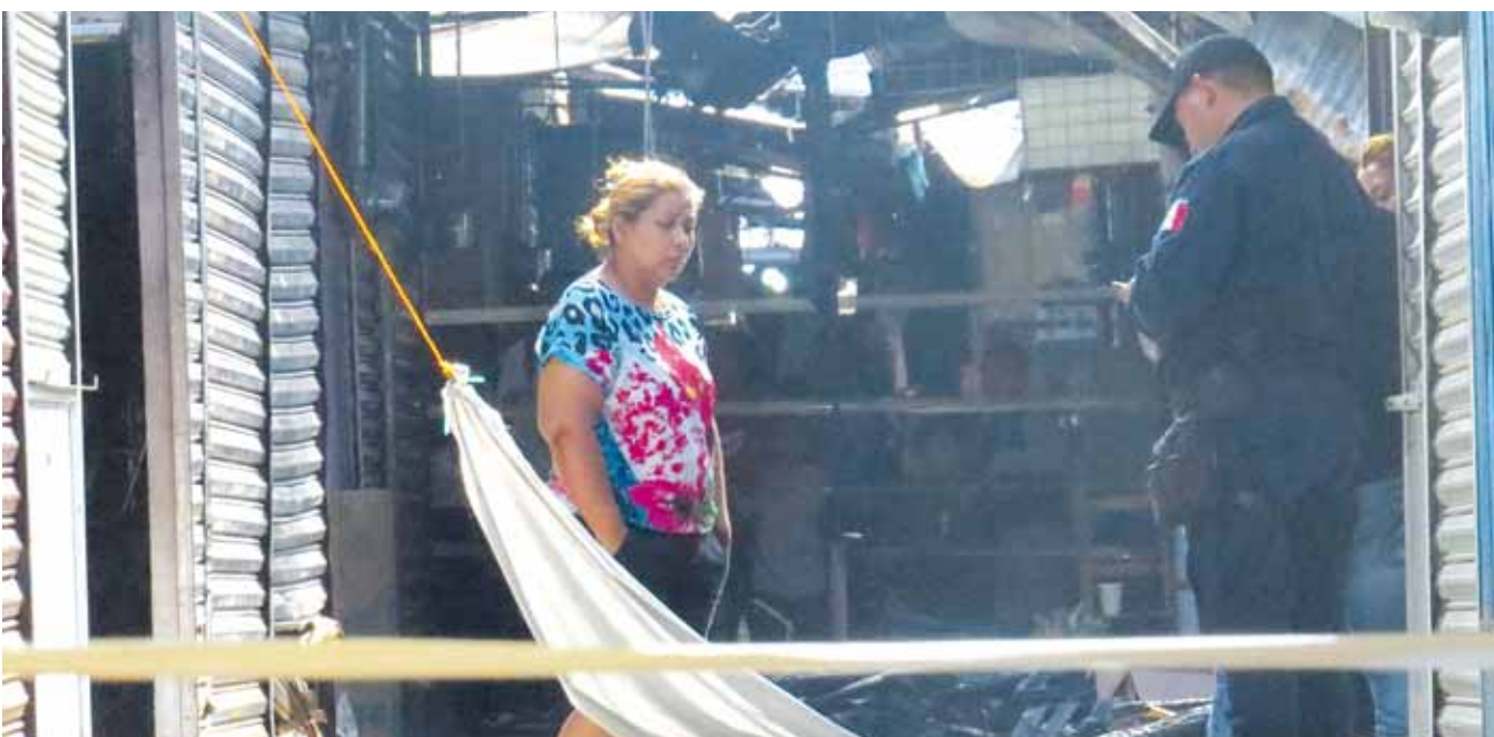
► El incendio del 2016 afectó 17 locales, los cuales fueron declarados pérdida total.
