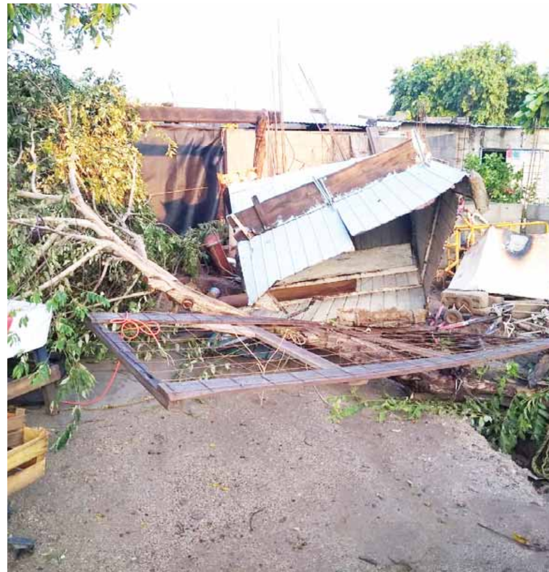
► La Turbonada provocó la caída de árboles y el desprendimiento de techos de lámina.
