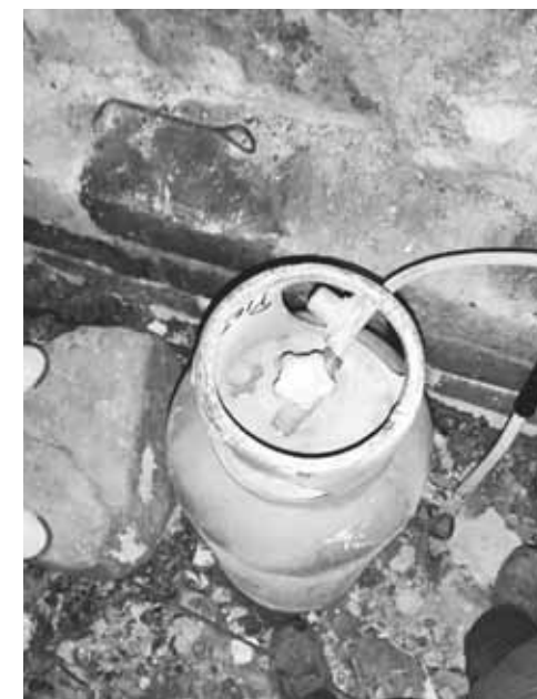
► Los tanques de gas presentan fugas.
