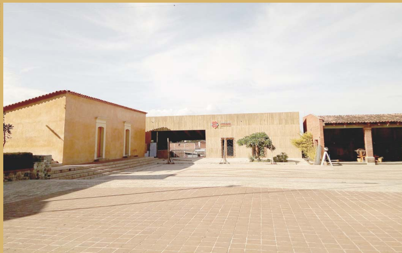
► El Centro Cultural Comunitario previo a su apertura en agosto de 2018.
