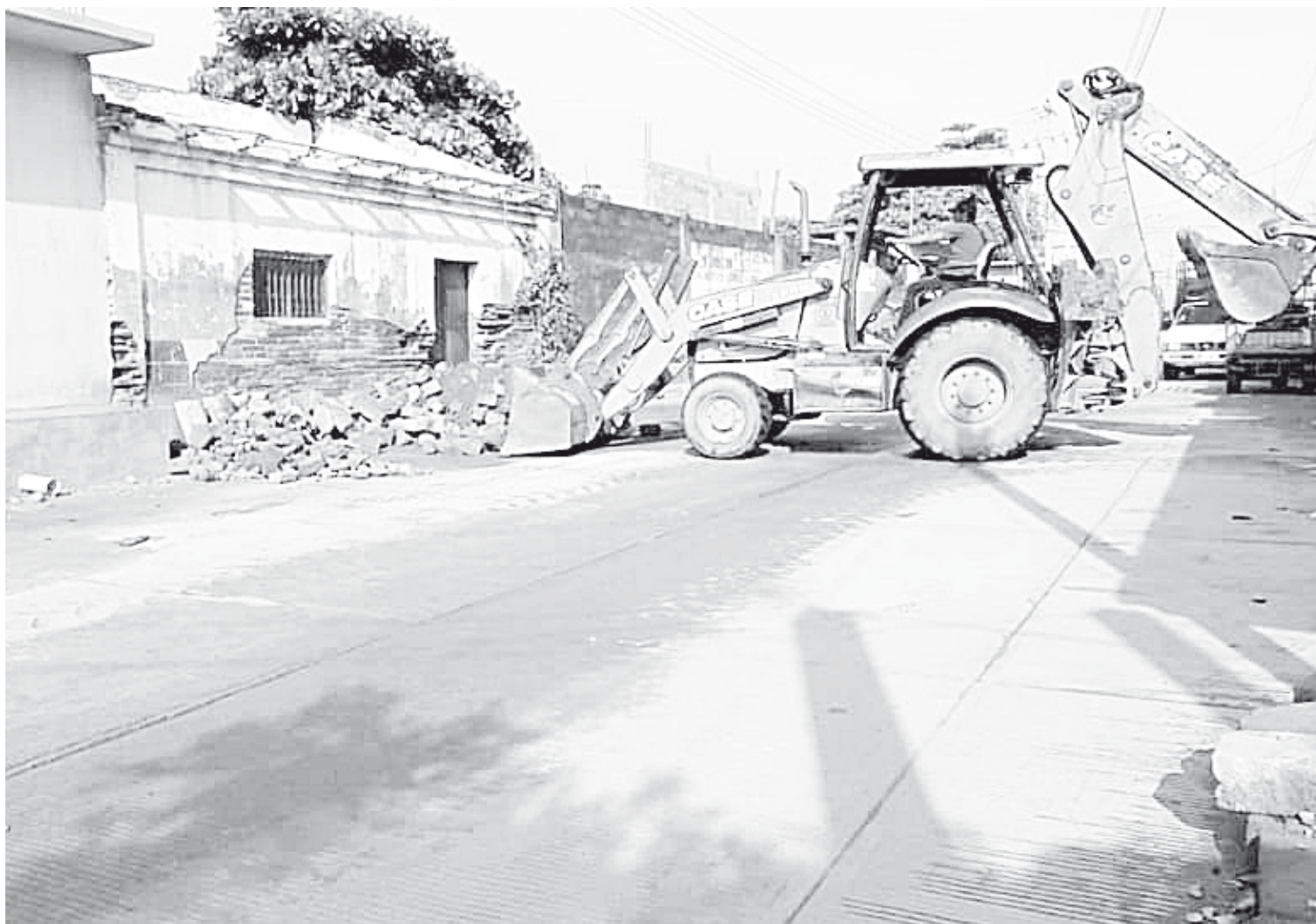
► Con maquinaria pesada se retiraron los desechos.
