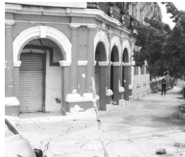
► El inmueble quedó dañado tras los terremotos del 7 y 19 de septiembre de 2017.
