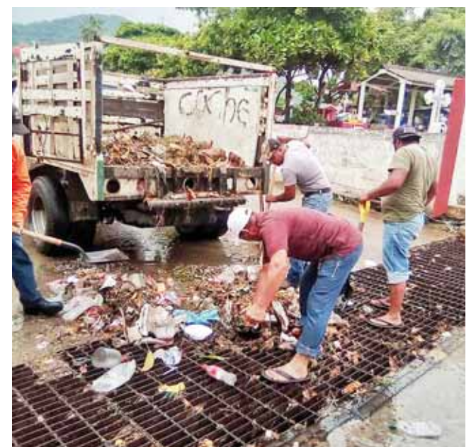
► Trabajadores de limpieza desazolvan coladeras.
