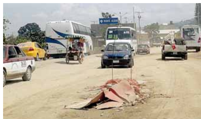
Las obras no se han podido concluir desde el año pasado.
