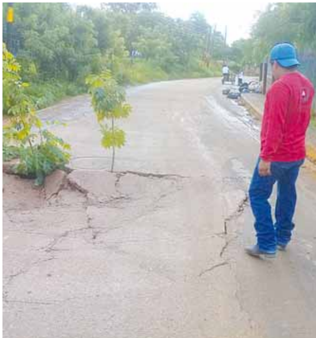
► Debido a las lluvias las carreteras se han visto afectadas.
