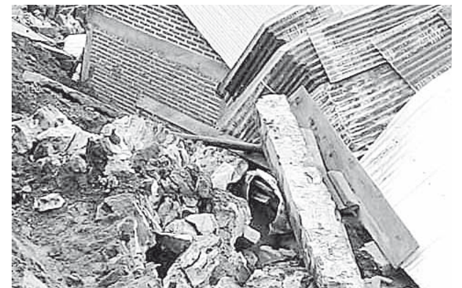
► Una decena de viviendas resultaron dañadas por deslaves.
