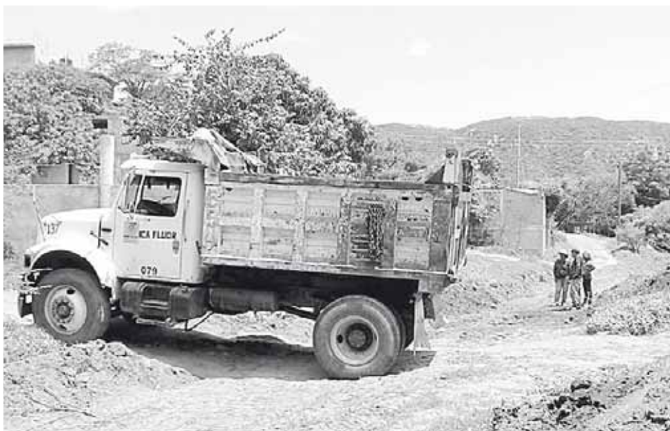
► Se ha retirado escombros para liberar las vialidades.
