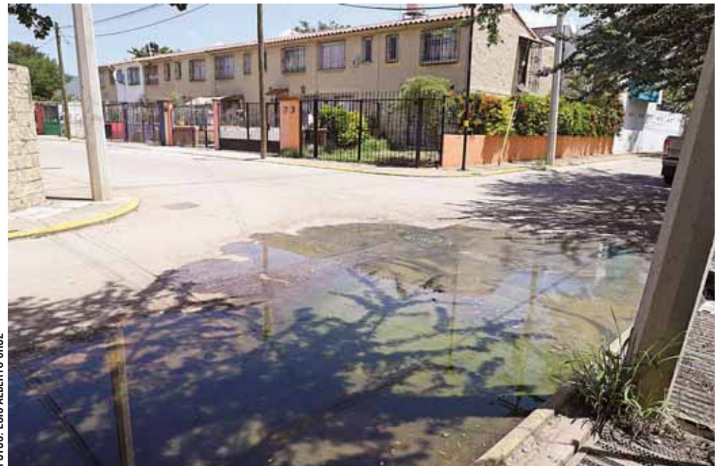
► Los fraccionamientos están siendo rodeados por aguas negras.
