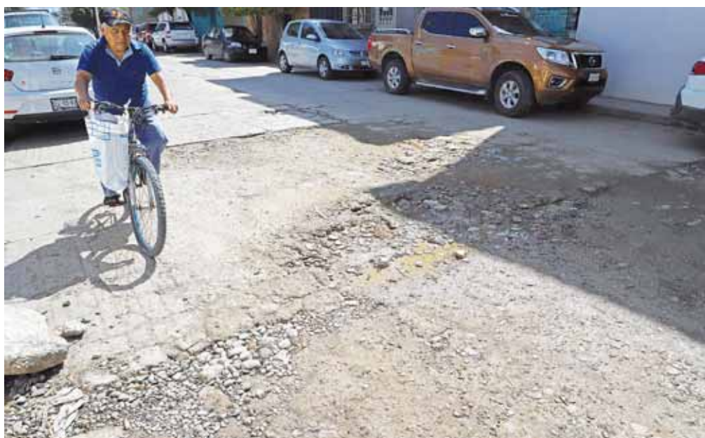
► Desde hace 30 años las calles no se han rehabilitado.
