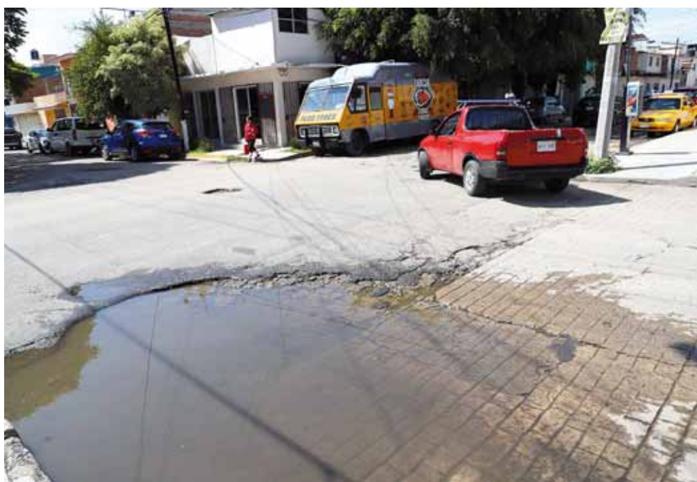
► Aguas fétidas quedan encharcadas en esta calle.
