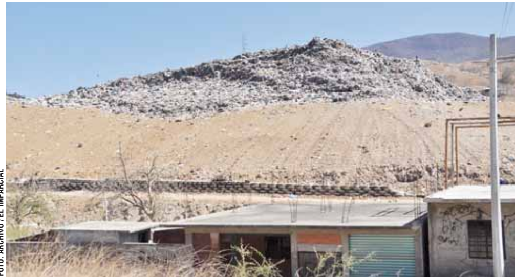
El relleno sanitario de la ciudad opera a cielo abierto en el municipio de Zaachila.
