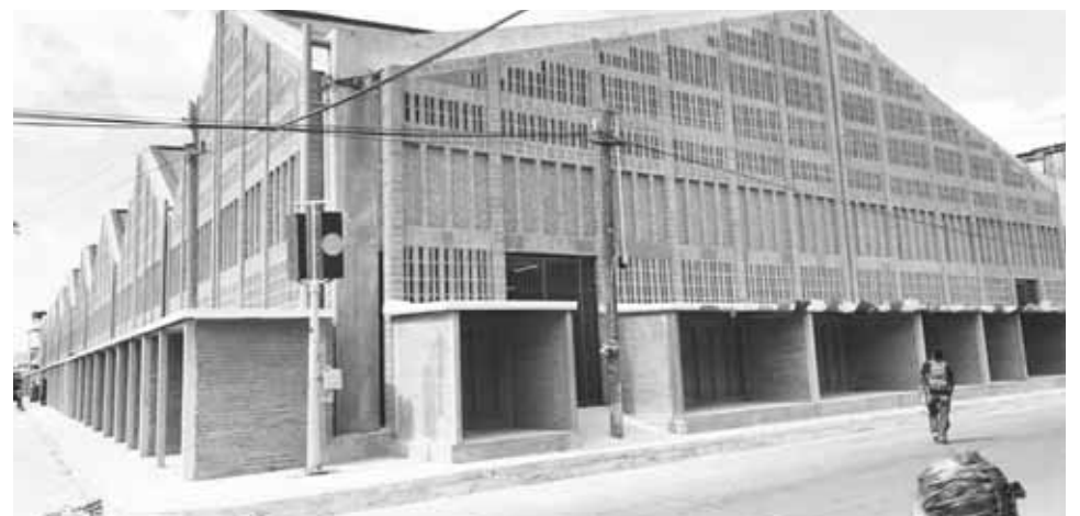
► Necesitan cerca de 800 mil pesos para la instalación de los tableros que alimentarían la luz de los locales del inmueble.
