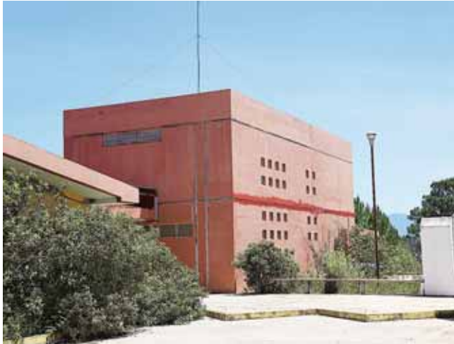
► El edificio se encuentra en el abandono.
