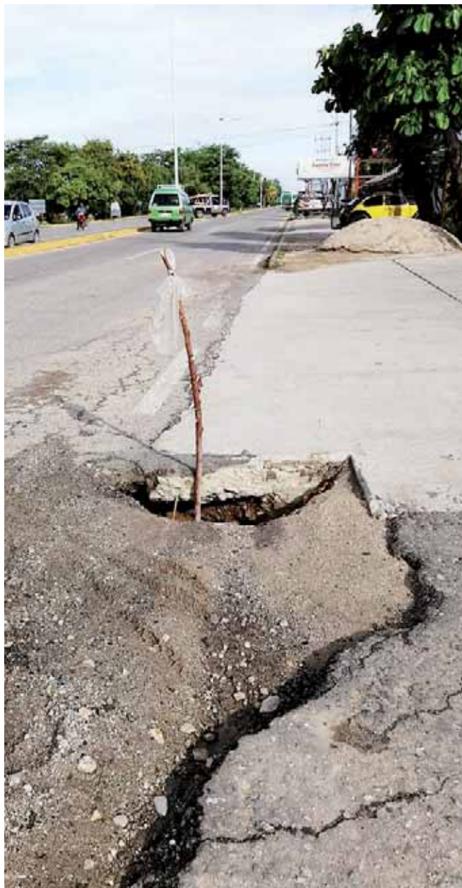
► La red de drenaje tiene problemas de fugas, tanto de agua potable como de aguas negras.
