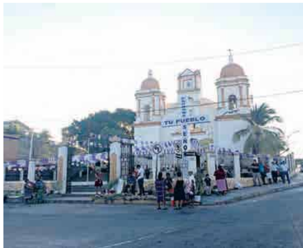
► No se registraron daños estructurales.
