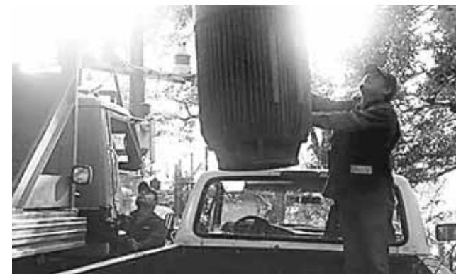
► Se trabaja en la reparación de la bomba.
