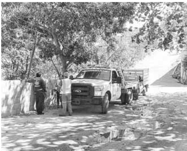
► Se atendió un poste propiedad de una empresa de telefonía.
