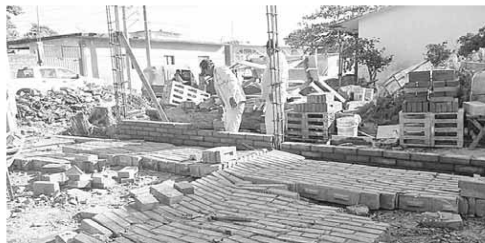
► A excepción de Xadani donde se cayó una barda en construcción, no se reportan daños.
