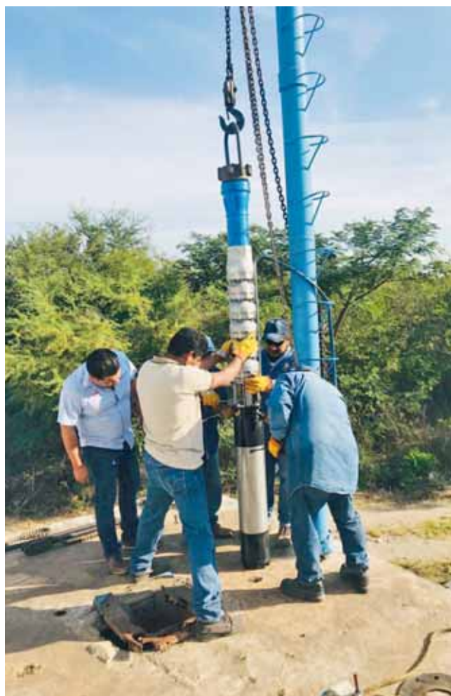
► El montaje consiste en la colocación de un equipo de 75 HP.
