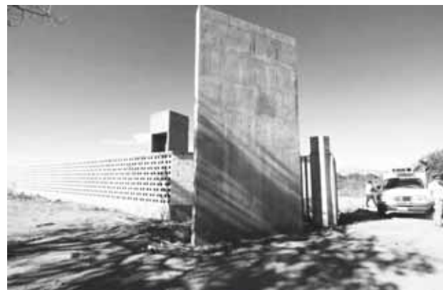
► Trabajan a marchas forzadas para concluir la obra.
