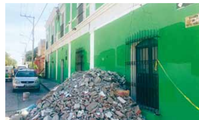
► Por su mal estado, el edificio representa un peligro para los transeúntes.
