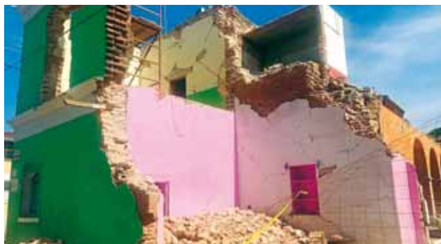
► Debido al daño sufrido por los sismos, la familia ha determinado demolerla.
