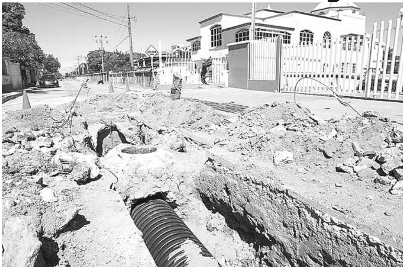
► Los trabajos constituyen la introducción de 430.30 metros lineales de tubería.
