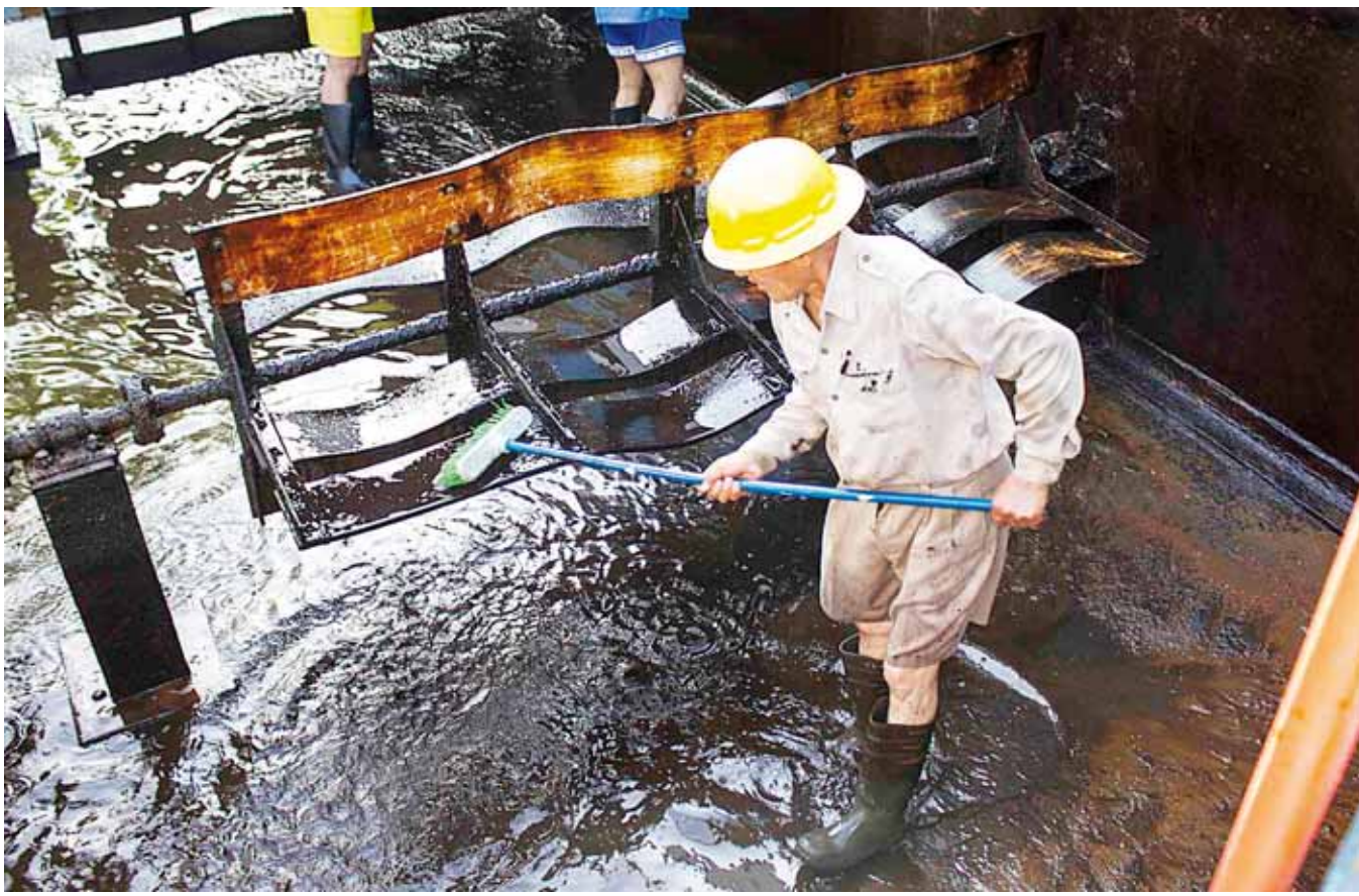
► La limpieza de los tanques concluyó desde el 12 de noviembre, pero aún no se normaliza el servicio.
