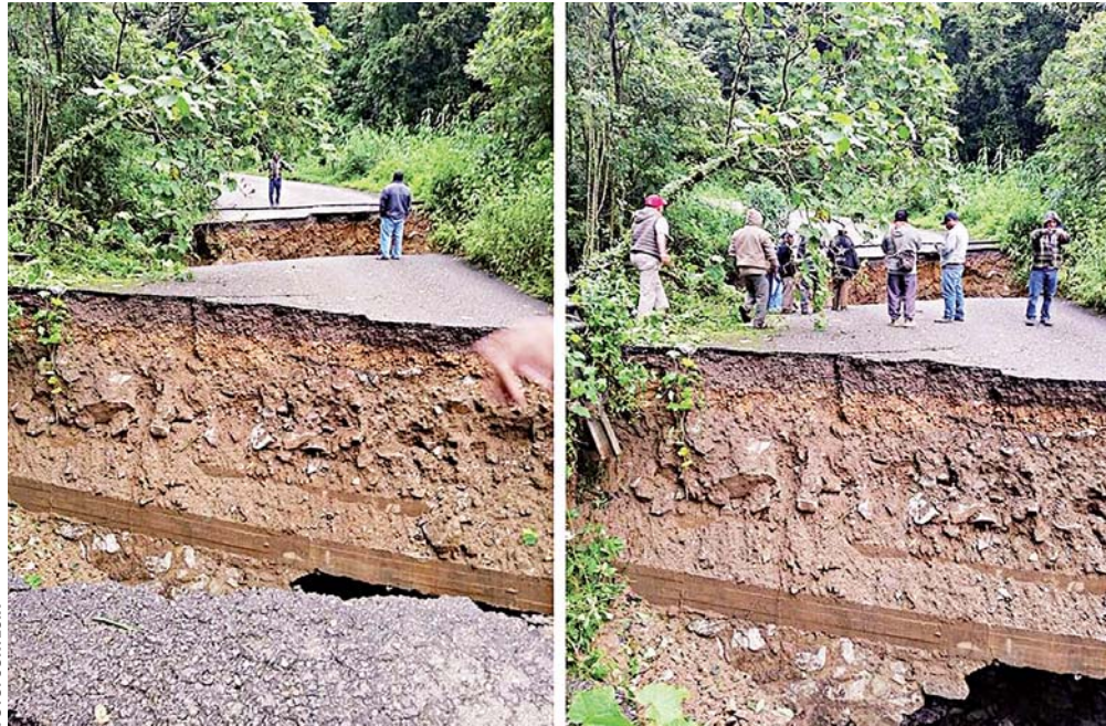
▶ La carretera a San Juan Metaltepec se partió en pedazos, el puente principal está derribado después de las intensas lluvias.
