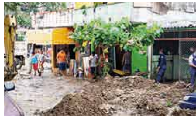
► Se presentaron al menos tres deslaves sobre la carretera federal 175.
