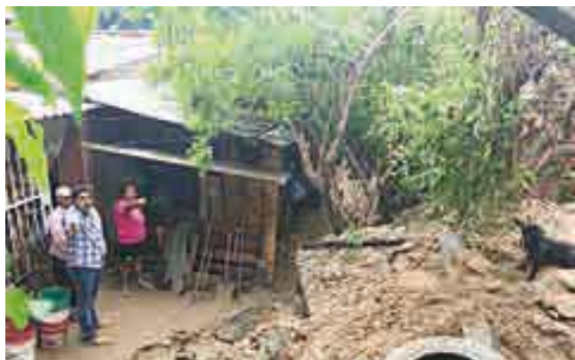
► En Jamiltepec, una barda de CECYTE se derrumbó.
