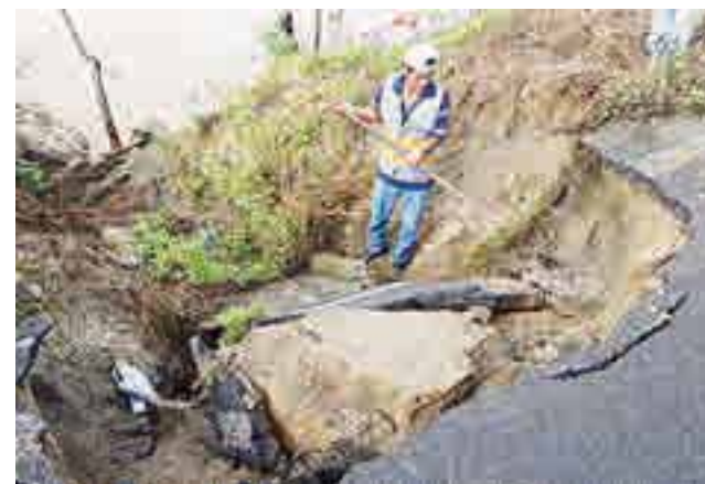
► En el puente auxiliar del Río Verde se registró un socavón.
