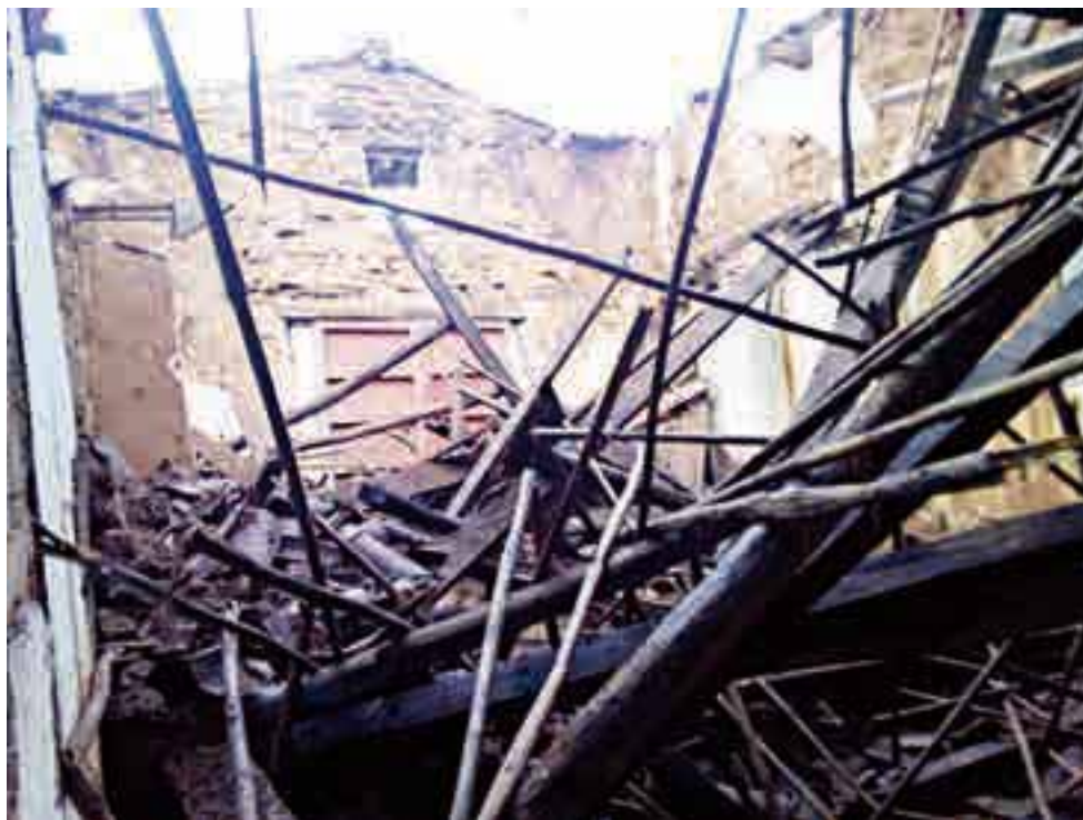
► La iglesia de Mechoacán ya se encontraba dañada por el tiempo y los temblores.
