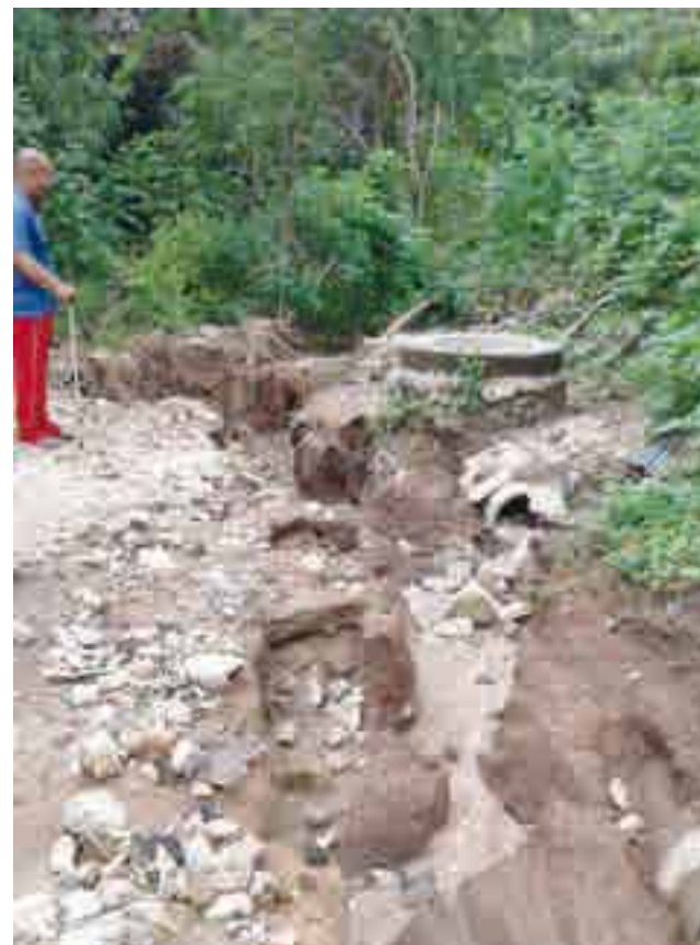
► Un ducto de 20 pulgadas de la red hidráulica fue dañado.
