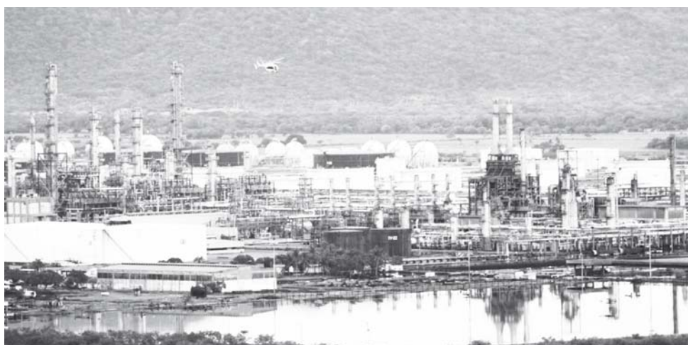
► La explosión en la casa de bombas en 14 de junio y el terremoto del 7 de septiembre del año 2017 afectaron la producción de la refinera.
