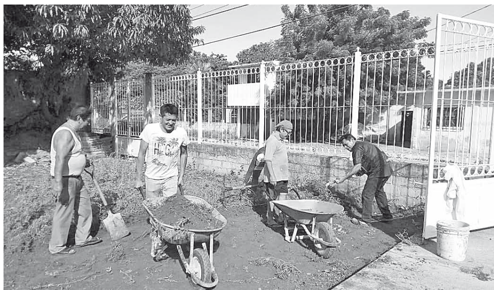
► Realizan trabajos de pintura y limpieza.
