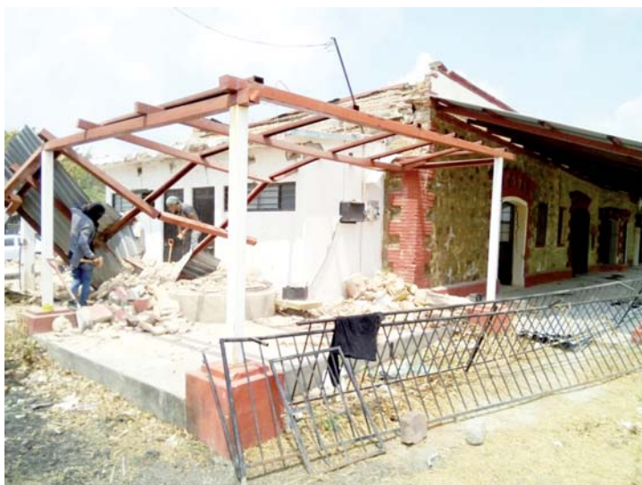
► Lleva un 50 por ciento de avance en su reconstrucción.
