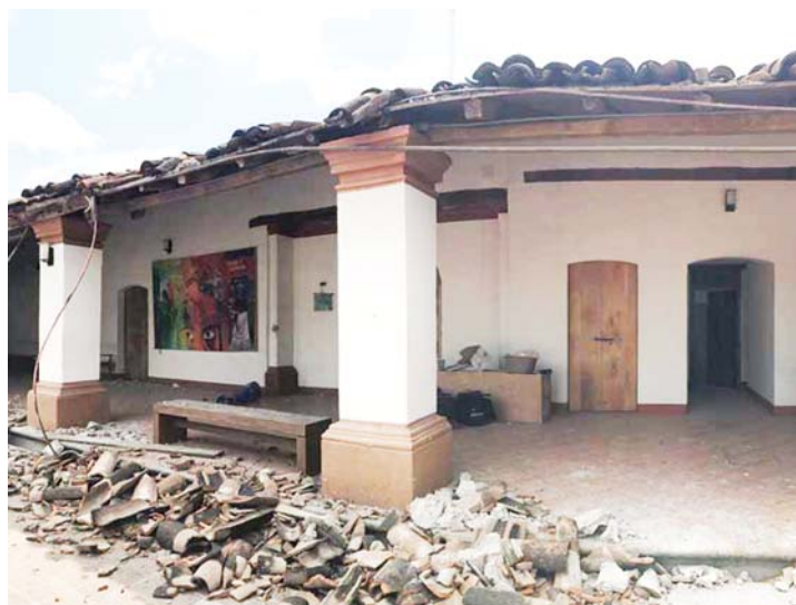
► La Casa de la Cultura de Juchitán tuvo grandes afectaciones.
