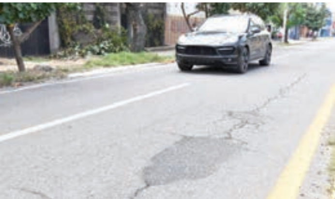
► Acciones de bacheo en frío.
