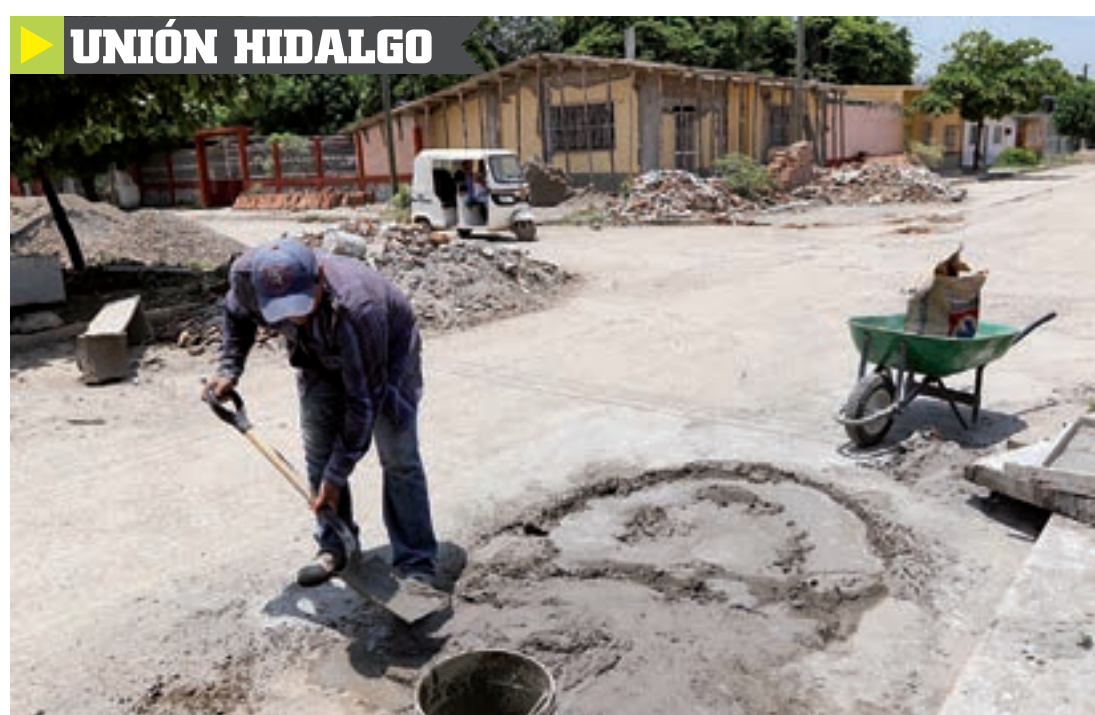
El aumento en los precios de los materiales y de la mano de obra, ha impactado en el proceso de reconstrucción de viviendas en el Istmo de Tehuantepec.
