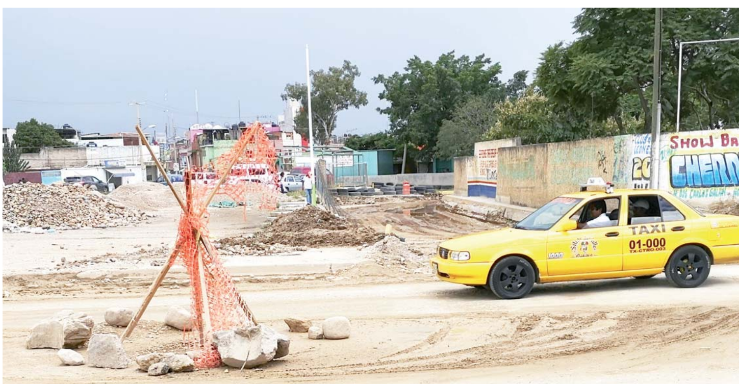
► Obra inconclusa en Margarita Maza. Ni siquiera colocaron el concreto hidráulico.
