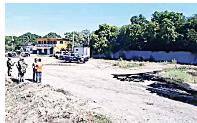
► Personal especializado realizó los trabajos de contención, recuperación y reparación.
