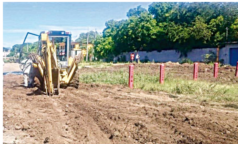
► Una vez que el personal de Pemex realice los trabajos de limpieza, se procederá a analizar la causa que originó este derrame.
