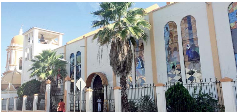
► La estructura se dañó durante el sismo de 7.2 grados de febrero.
