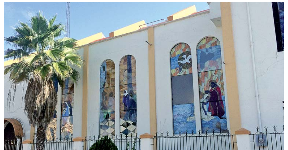
► El templo presenta cuarteaduras y los vitrales rotos.
