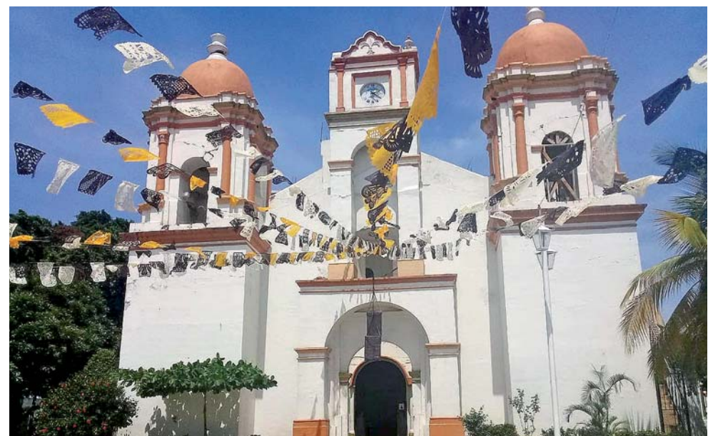
► El templo presenta cuarteaduras y los vitrales rotos.
