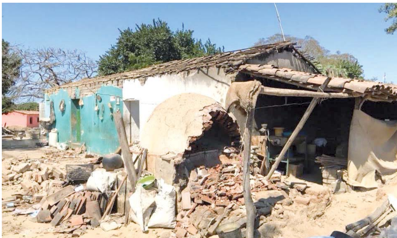
► Se pronuncian a favor de los damnificados del sismo del 16 de febrero.
