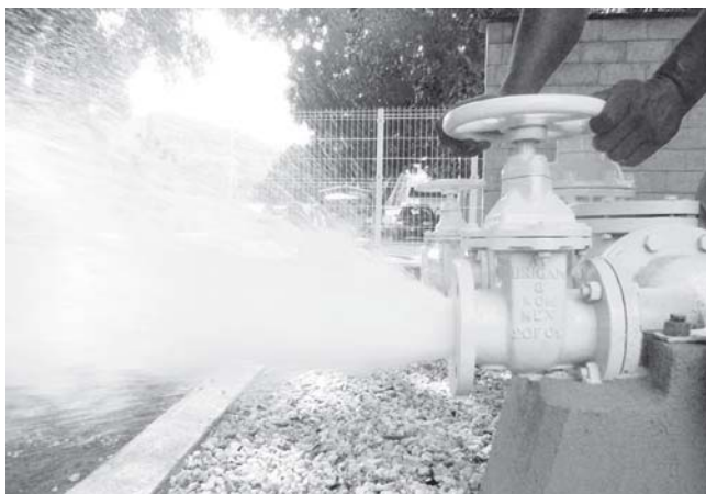
► De inmediato se puso a funcionar el pozo afectado.
