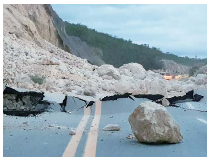
► Rocas y tierras dañan la carpeta asfáltica en la súper carretera.
