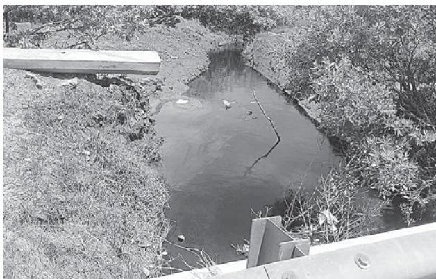
► Personal especializado actúa para atender la presencia de hidrocarburo.
