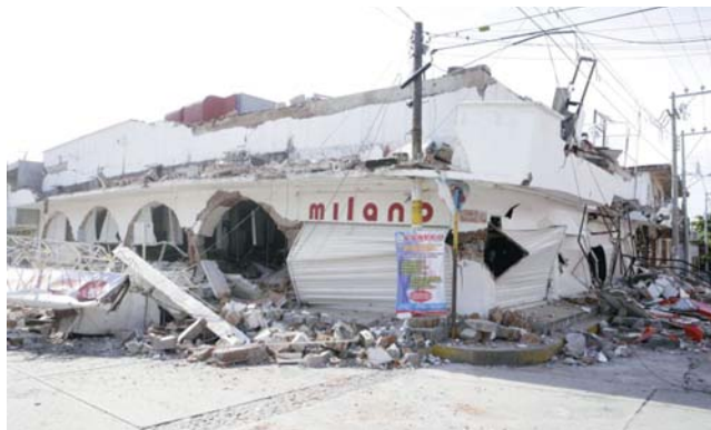
► Durante la emergencia se prometieron apoyos, pero solo les dieron 10 mil pesos.
