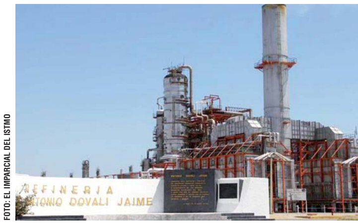
► La refinería Antonio Dovalí Jaime enfrenta serios problemas para operar al cien por ciento, debido a los daños por el terremoto de septiembre pasado.
