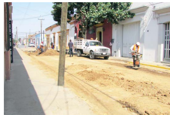
► Piden que se agilicen las obras.
