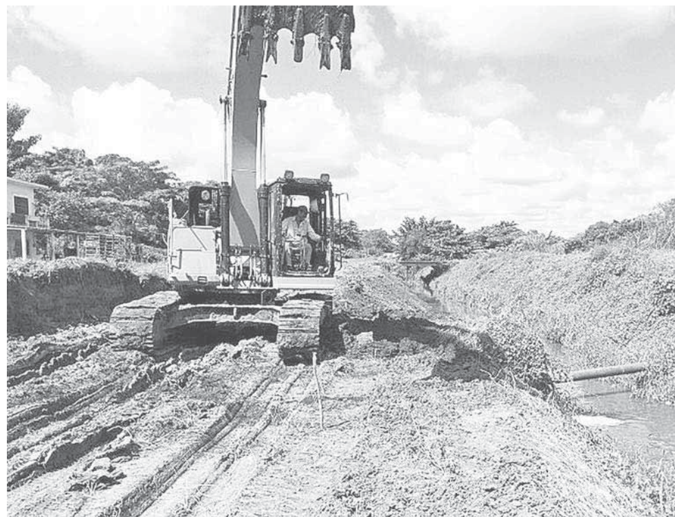
► Los trabajos van avanzado en tiempo y forma en Benemérito Juárez, donde se inundó en octubre pasado tras las fuertes lluvias.
