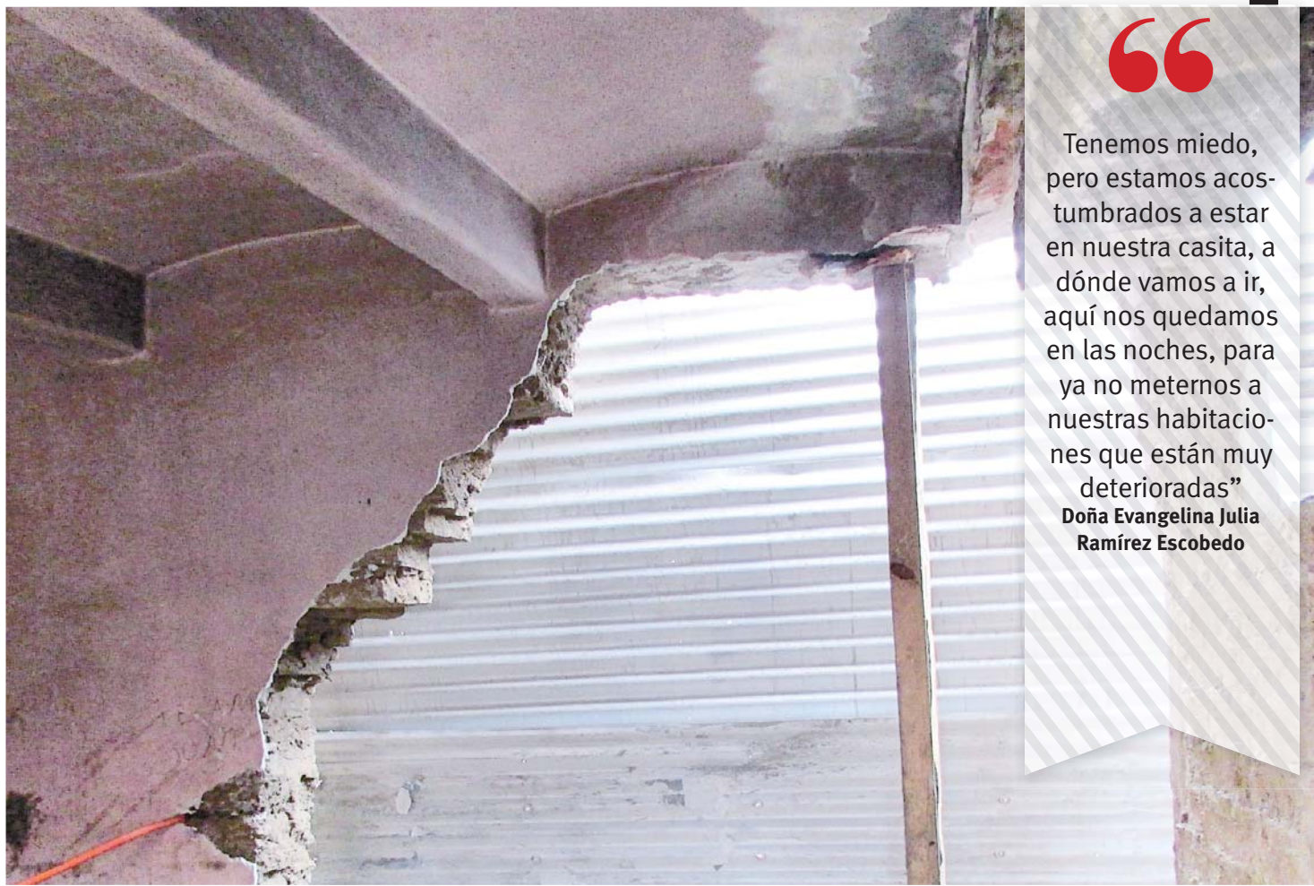
► Tiene daños severos en la estructura.
