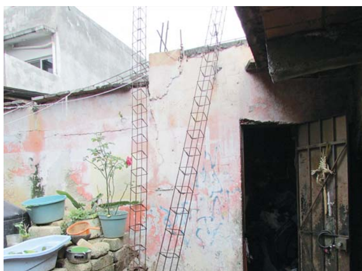
► La casa ha resistido los dos sismos recientes.
