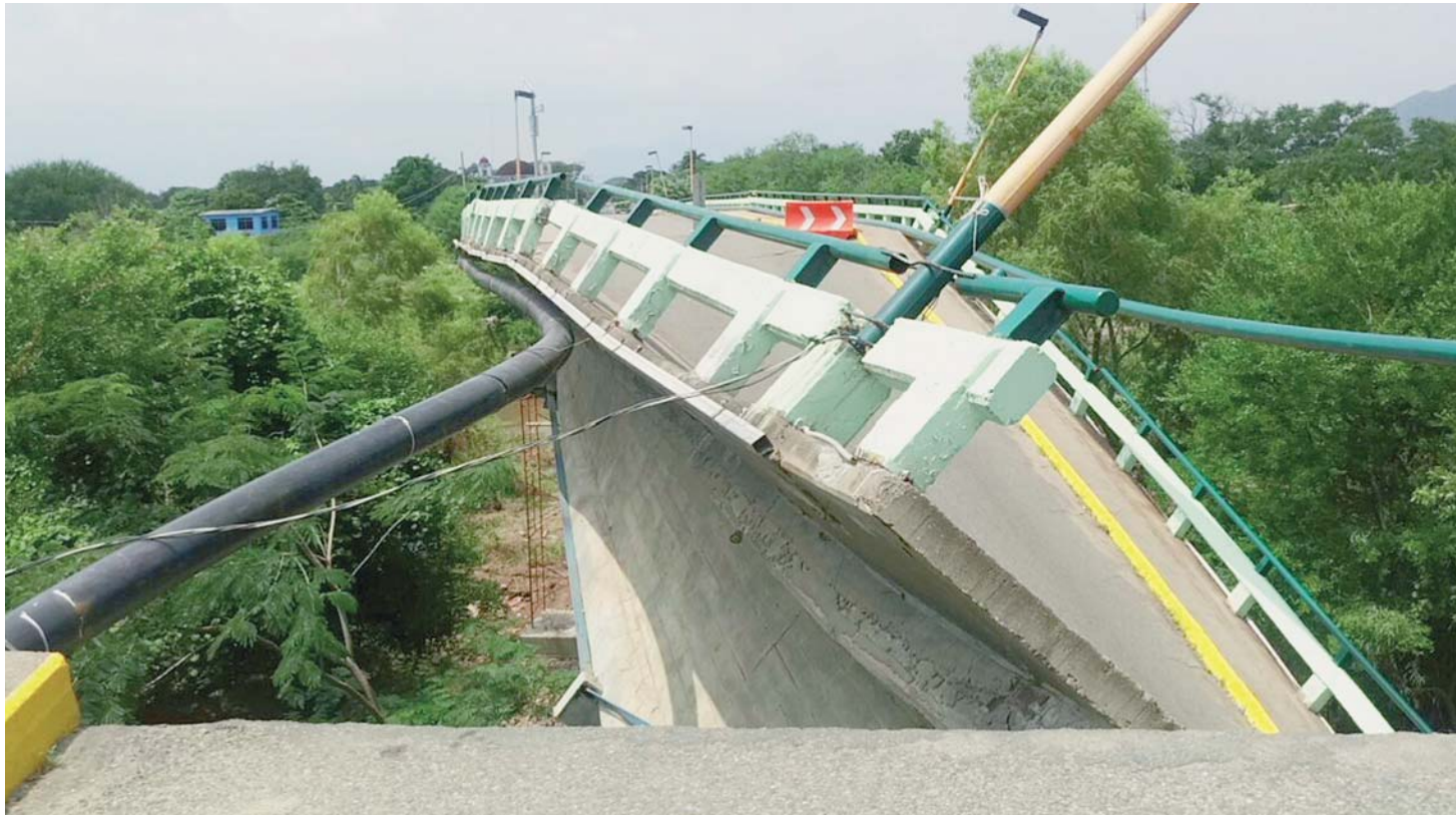
El puente "Los Perros", que servía como entrada principal a Ixtaltepec, colapsó definitivamente.
