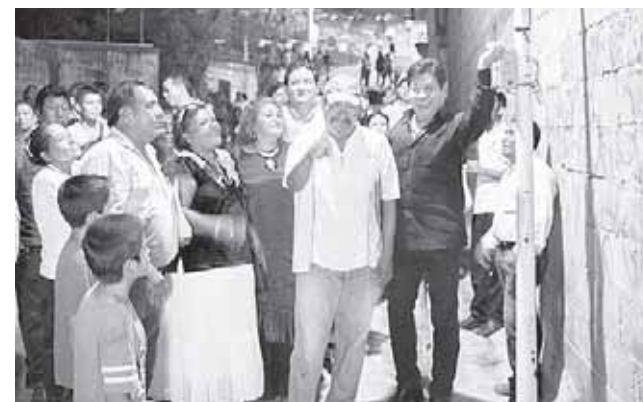
► La ampliación de la red de distribución eléctrica beneficiará a cerca de 150 personas.
