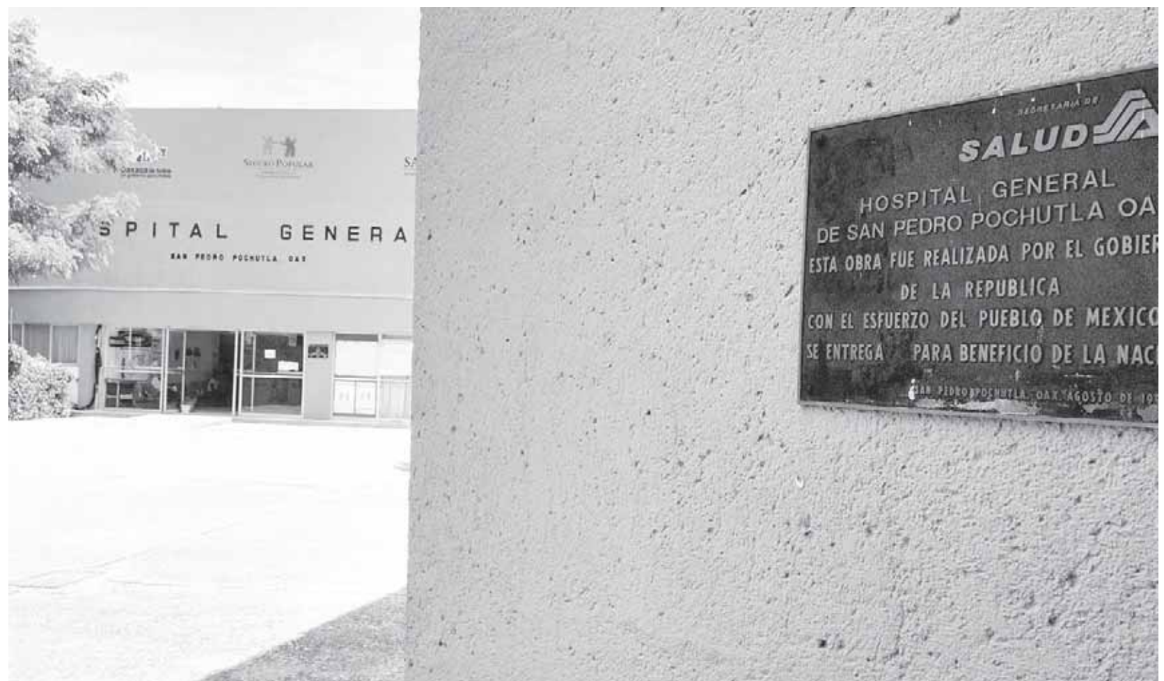
► Dos años detenidas las obras de rehabilitación del área de gobierno del nosocomio.
